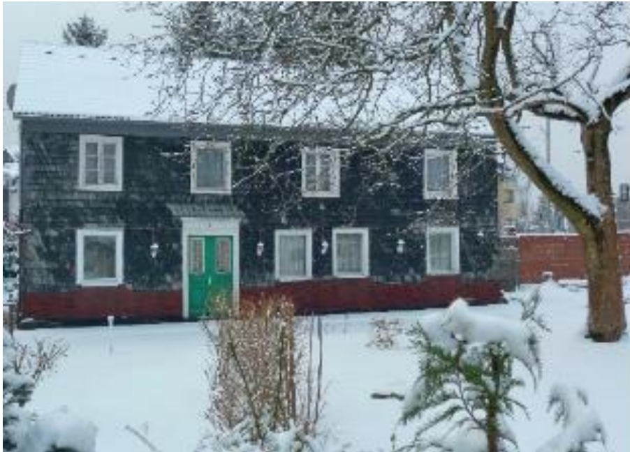
Abbildung 2: ehemaliges Gesindehaus Püttbachhof, abgerissen 2022. Foto Uwe Berndt 16.1.2013
